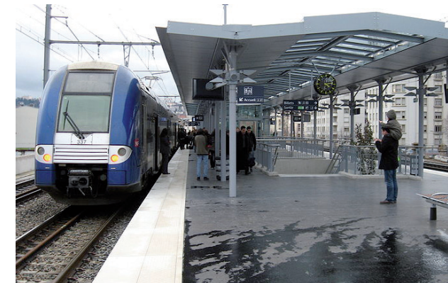
Réalisation de la gare Jean Macé (69)
