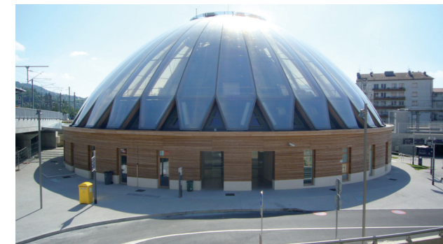
Réalisation du PEM de Bellegarde-sur-Valserine (01)
